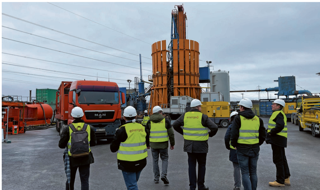
Exemple d'un site de forage géothermique: la Commission de suivi et d'information (CSI) en visite à Vinzel (VD) au mois de mars 2023.
